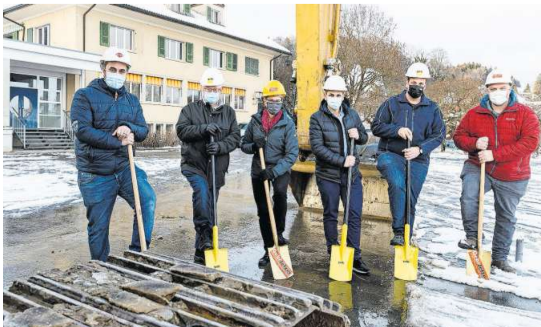
Am symbolischen Spatenstich in Aetingen für den Beginn der Bauarbeiten rund um das alte Schulhaus nahmen teil (von links): Sven Neyer (Architekt), Thomas Stutz (Gemeinderat Buchegg), Verena Meyer (Gemeindepräsidentin Buchegg), Michel Vogt (Galli Hoch und Tiefbau AG), Bruno Bartlome (Gemeinderat Buchegg) und Reto Jetzer (Gebrüder Jetzer Hoch und Tiefbau AG). Bild: Hanspeter Bärtschi
